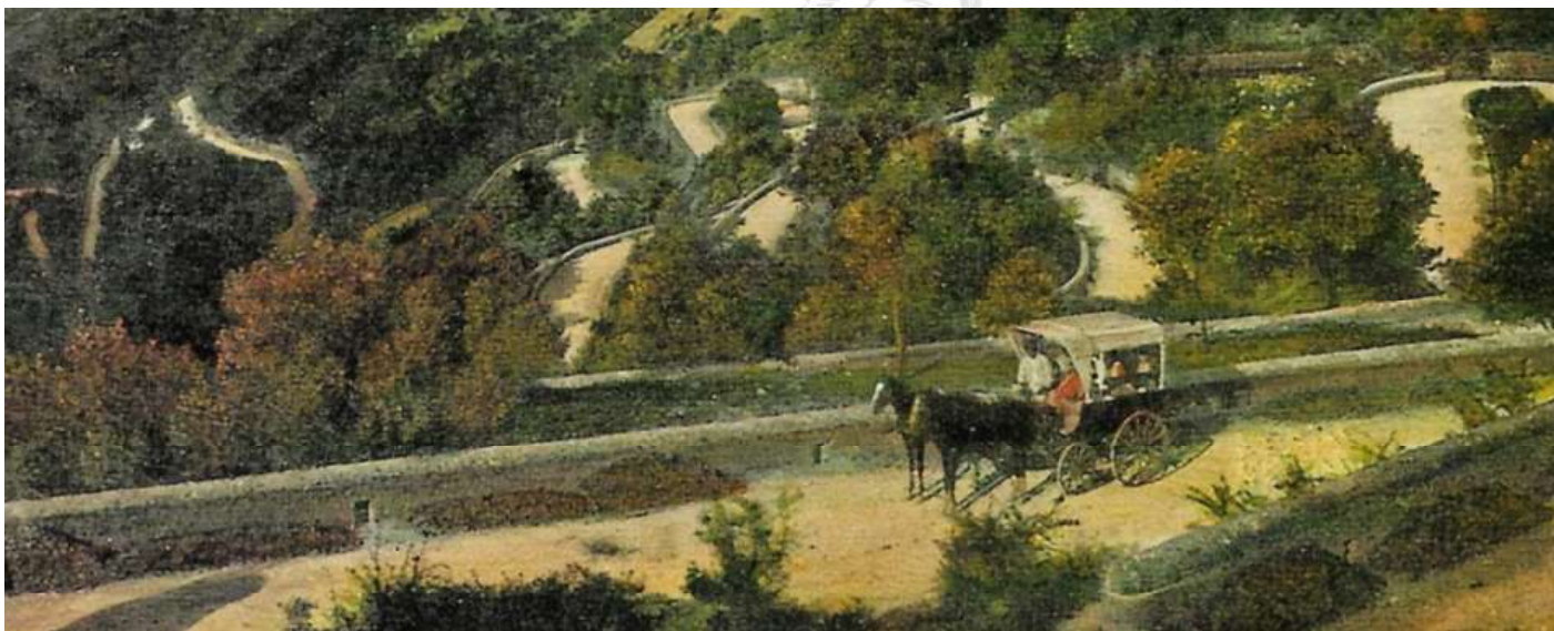
Carretera del Coll (construida en 1847)
